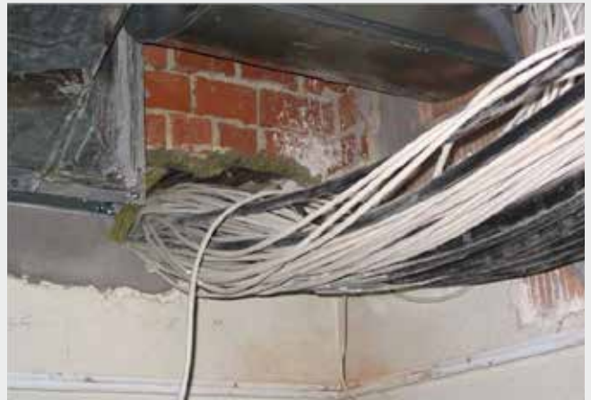
Assenza di supporto per cavi e riempimento > 60% della superficie dell'apertura
