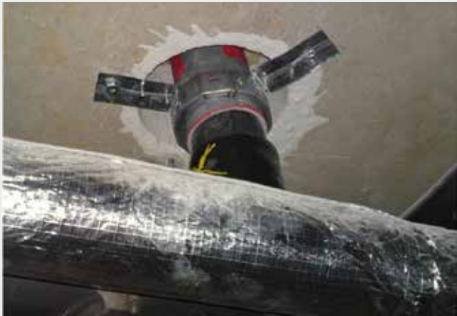
Lo spazio anulare restante tra tubo e muro non è stato chiuso
