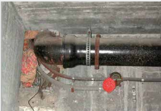
Chiusura con materiale non idoneo (calcinacci, sacchi, materiale di risulta)
