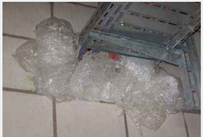
Chiusura con materiale non idoneo (nylon)
