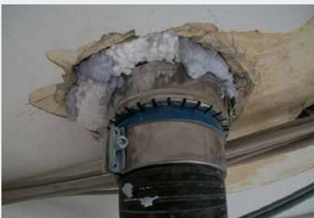
Chiusura dello spazio anulare restante tra tubo e muro con materiale non idoneo (polistirolo) e manicotto non fissato al solaio
