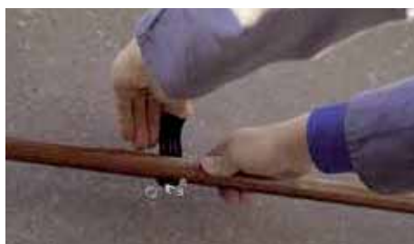
Aprire il collare, posarci il tubo.
