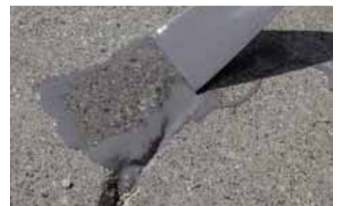
Riempimento di crepe
