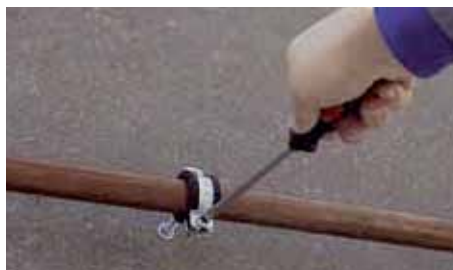
Aprire e procedere alla chiusura finale agendo con un cacciavite.
