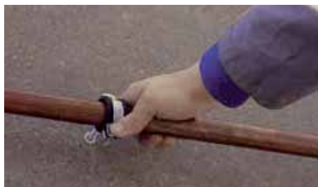
Fissare premendo sulla testa della vite.
