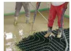
5. Getto a cura del massetto fluido autolivellante idoneo per applicazioni su sistemi di riscaldamento a pavimento ribassati.
