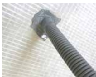
Sigillatura di tubi corrugati.
