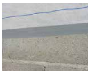
Sigillatura e fissaggio di schermi freni o barriere al vapore sulla struttura muraria.
