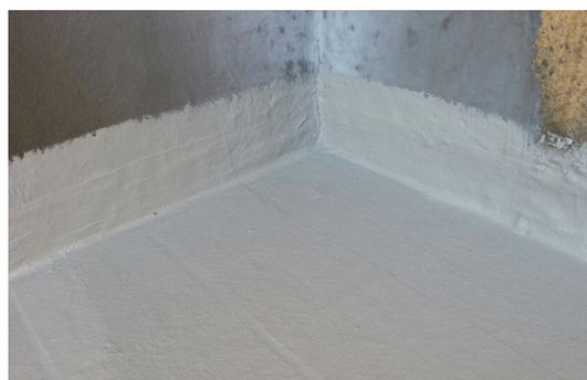
Risvoltare l'intera procedura di impermeabilizzazione nelle intersezioni con gli elementi verticali.
