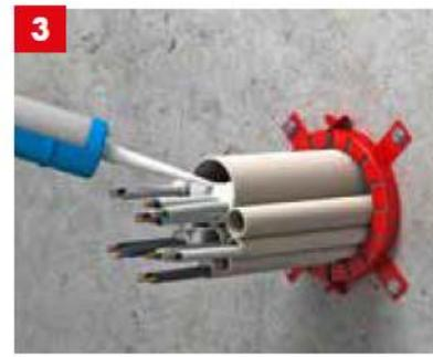
Ancorare il manicotto con tasselli metallici o, in caso di pannelli in cartongesso, con barre filettate passanti e dadi. Sigillare i tubi portacavi con **Sigillante acrilico ACR 240** per una profondità min. di 10 mm da entrambi i lati della parete o del solaio
