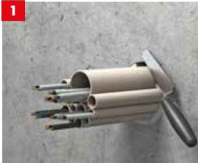
Riempire la totalità dello spazio anulare restante tra tubo portacavi o fascio di tubi portacavi e struttura con malta cementizia o gesso, per l'intero spessore della parete o del solaio
