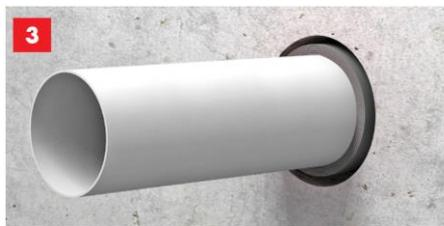
3 Spingere il nastro nel foro fino a quando il suo bordo esterno è a livello con la superficie della parete o del solaio
