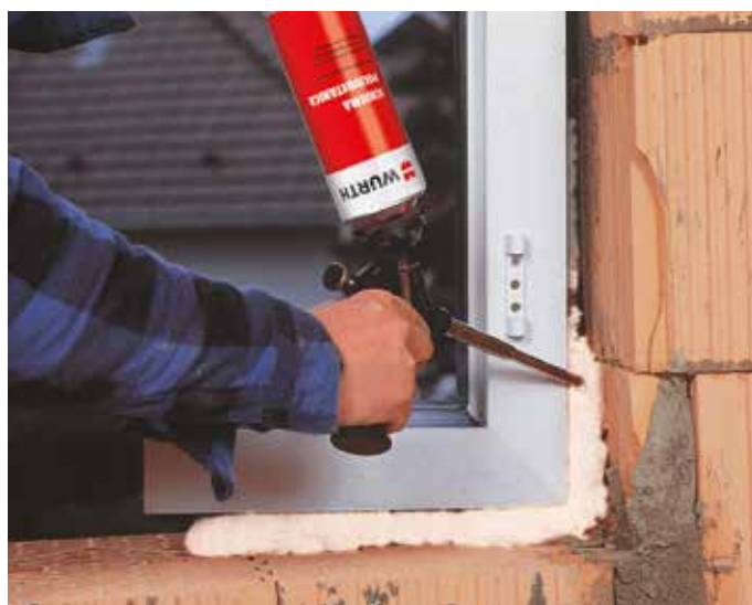
Montaggio di infissi
