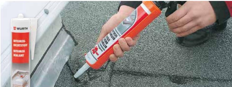
**Sigillante monocomponente a base di bitume per sigillature su guaine bituminose**
