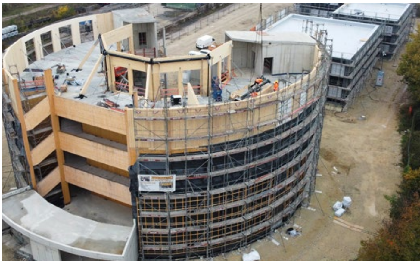
Würth / Ingenieurgruppe Knörnschild & Kollegen Costruzione del nuovo teatro Globe di Coburgo, completamente in legno, grazie a Würth.
