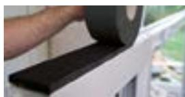
1. Pulire il telaio del serramento ed applicare il nastro, dal lato autoadesivo, lasciando 2 cm di materiale in eccesso per ogni metro lineare (creare delle „Onde“)
