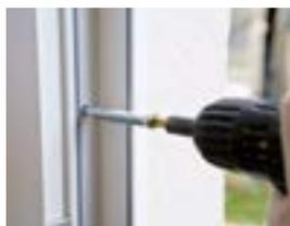
6. Fissare alla struttura tramite viti AMO III (Art. 0234 ...)
