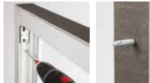
6. Terminata l'applicazione del nastro posizionare il serramento nella sua sede ed eseguire il fissaggio meccanico tramite viti AMO III Art. 0234 ...
