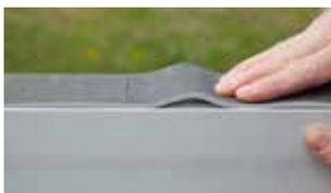
5. Se il rotolo termina a metà dell'applicazione, proseguire con uno nuovo senza lasciare alcun spazio, premendo accuratamente uno spezzone contro l'altro.
