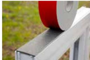
2. Pulire il telaio del serramento ed applicare il nastro dal lato autoadesivo sul profilo dello stesso, lasciando 2 cm di materiale in eccesso per ogni metro lineare (creare delle "Onde").
