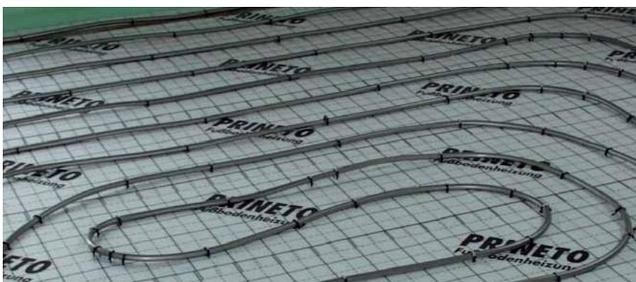
Dopo aver posato il massetto dovrà essere effettuato il bilanciamento idraulico dei singoli circuiti a pavimento e l'avviamento iniziale del riscaldamento.
