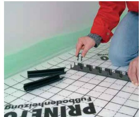
In base al tipo ed al passo di posa prescelto, inserire il tubo direttamente nelle scanalature dei binari di fissaggio mediante pressione con il piede. Nei tratti di curvatura i tubi vengono invece fissati a dei piccoli pezzi di binario oppure con alcuni chiodi di fissaggio RAP, sempre rispettando il raggio di curvatura minimo, pari a 8 volte il diametro esterno del tubo.
