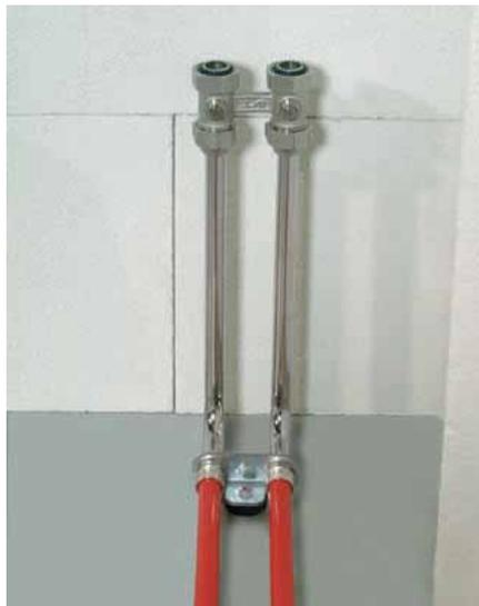
Collegamento alla valvola radiatore tramite tubo **Prineto** Riscaldamento (rosso) e tubo **Prineto** Stabil (bianco).
