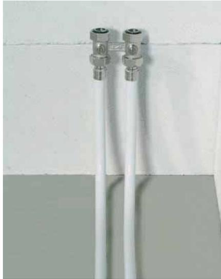
Collegamento alla valvola radiatore tramite tubo **Prineto** Riscaldamento (rosso) e curva d'allacciamento **Prineto**.
