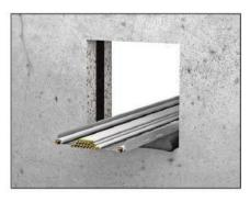
Se possibile, collocare uno strato di cuscini al di sotto del fascio di cavi o della passerella portacavi.
