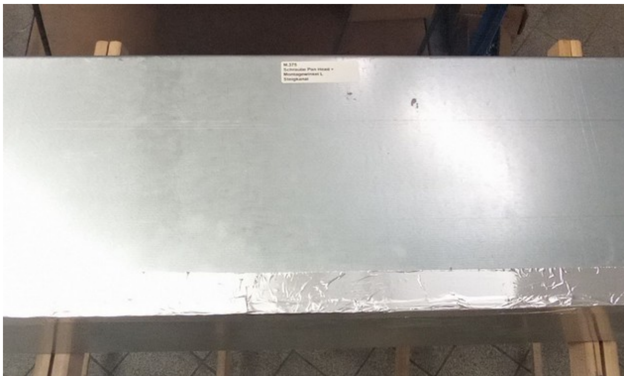
Immagine 7.10: Canale di areazione senza elementi angolari di montaggio per canali di areazione Würth VARIFIX® di tipo 2 + viti WÜRTH di tipo 1
